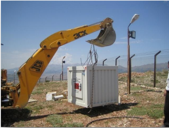
Şekil 3.1.1. Türkiye Ulusal Deprem İzleme istasyonlarının kurulumuna bir örnek
