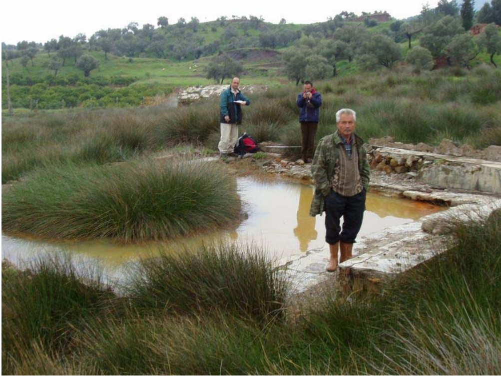
Şekil 17. Cumalı kaplıcası yakın güneyinde 1992 öncesinde Tuzla fayı üzerine inşa edilmiş beton temel tabliyesinde sağ yönde ötelenme izlenmiş ve bunun 1992 depremi sonucu geliştiği yorumlanmıştır (bakış güneydoğuya).
